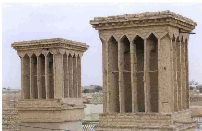
La parte alta di due "torri del vento" iraniane. Qui si incanala l'aria per la "climatizzazione" della casa sottostante. (Foto Silvana).
